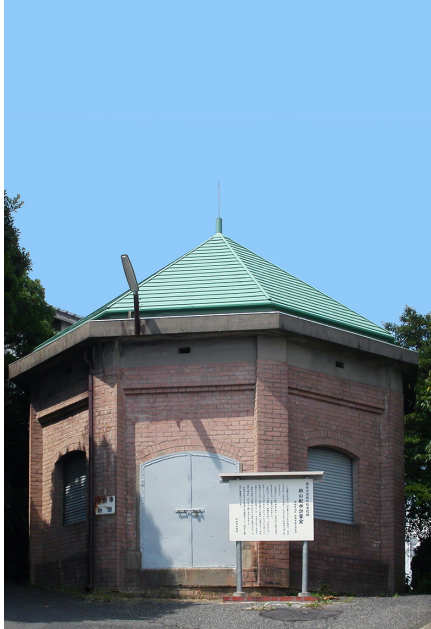
ももやま 桃山配水計量室 (宇部市大字小串)
